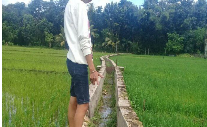
Gambar 4. Saluran Drainase di Sawah
