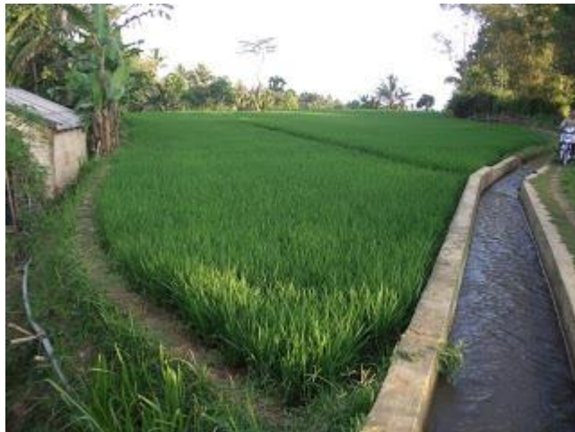
Gambar 3. Saluran Irigasi Tersier
