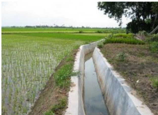
Gambar 2. Saluran Irigasi Sekunder
